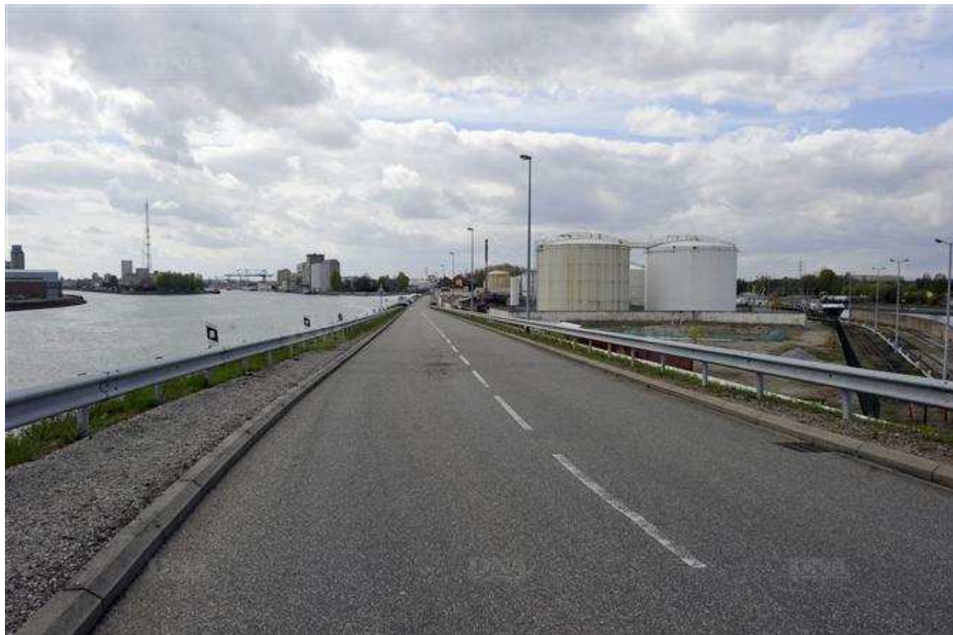
Quai Jacoutot, les cuves de Rubis Stockage. Photo archives DNA
